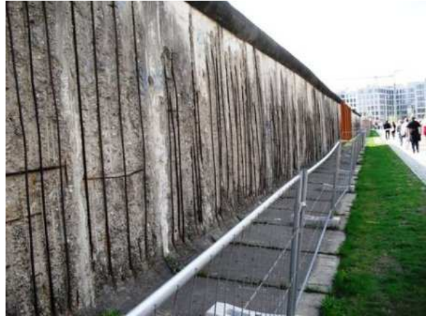
Tästä näkee muurin rakenteen ja L-muodon.
