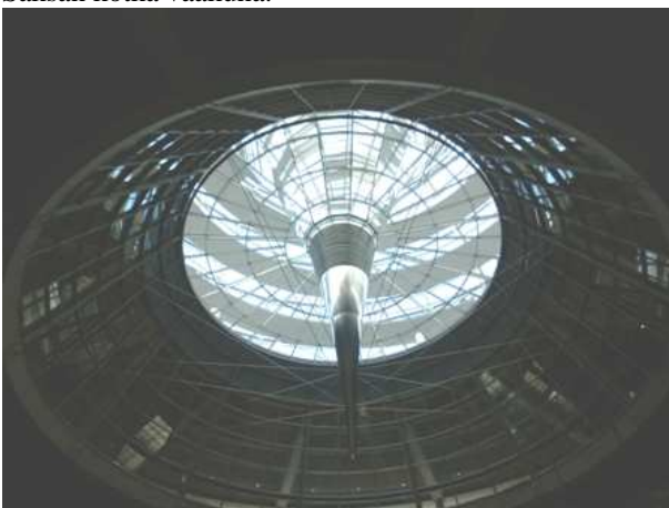
Valtioväätalon kupoli sisältäpäin.
