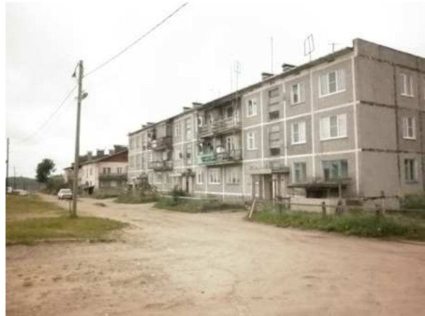
Kerrostalotkin olivat aika huonossa kunnossa.
